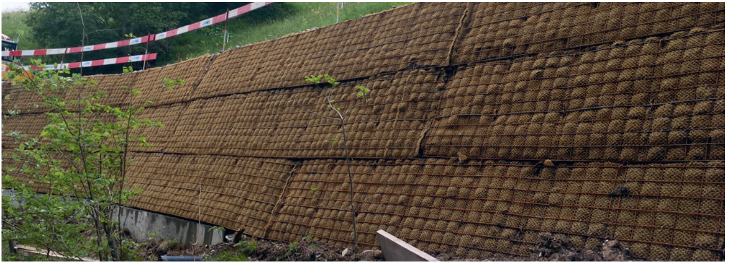
Bauarbeiten für die Erstellung eines erdbewehrten Stützsystems.
