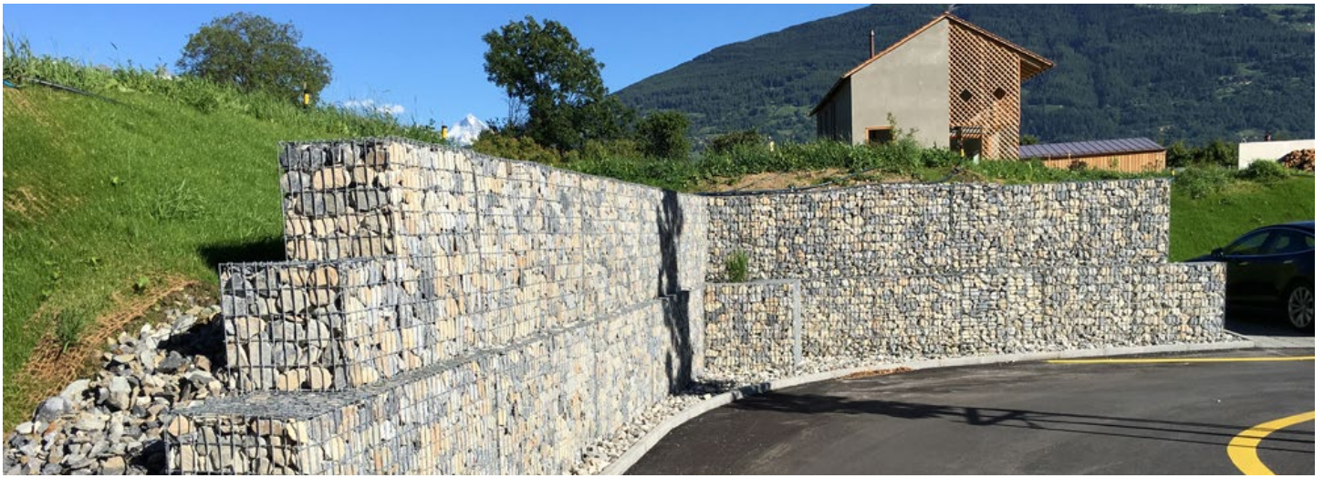
Gabions formant un ouvrage de soutènement le long d'une route.
