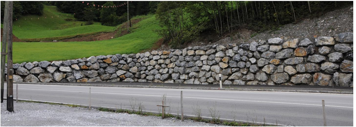
Muro con blocchi ciclopici quale opera di sostegno lungo una strada.
