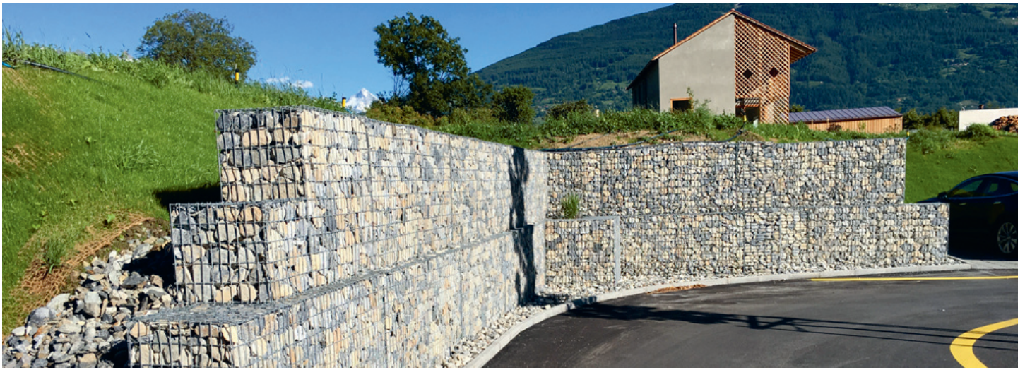
Steinkörbe als Stützbauwerk entlang einer Strasse.
