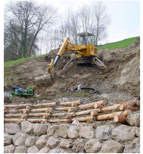
Verschiedene ingenieurbio-logische Massnahmen: Saaten (links), Buschlage (mitte), begrünter Holzkasten (rechts).
