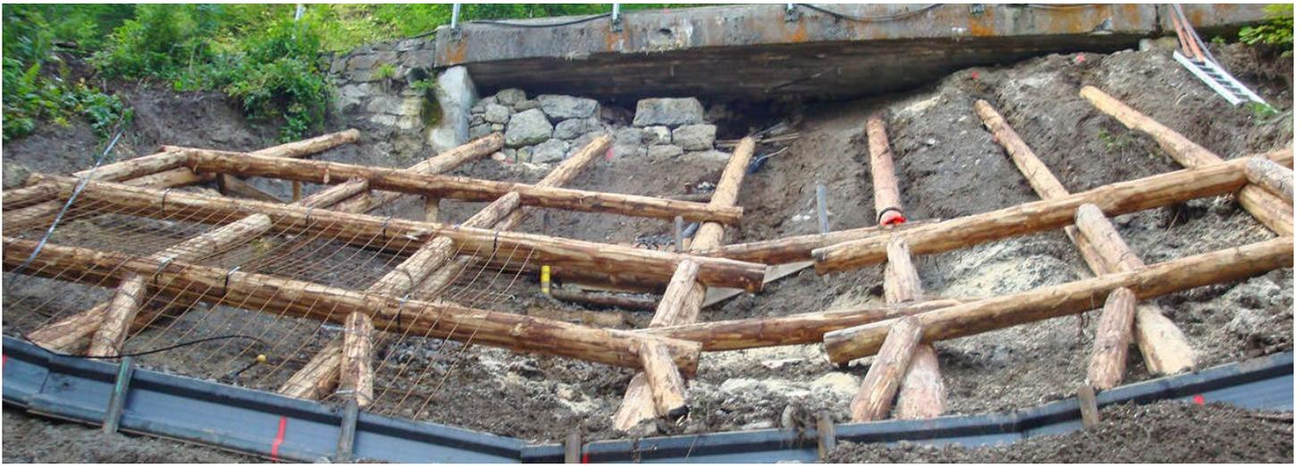
Pose d'une armature de pente dans un talus présentant un risque d'arrachement.
