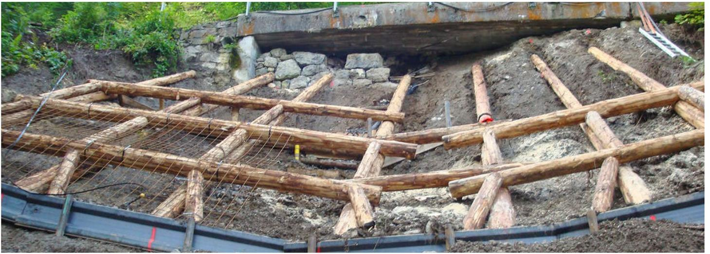
Einbau eines Hangrostes an einer abbruchgefährdeten Böschung.
